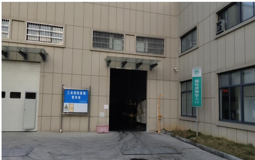
图 4-4 危险废物贮存场所
