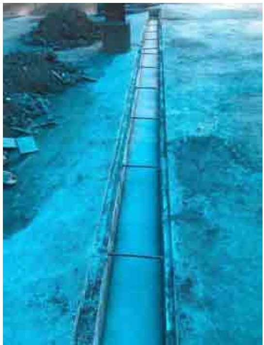
运输车辆洗胎区防渗漏、外流措施
