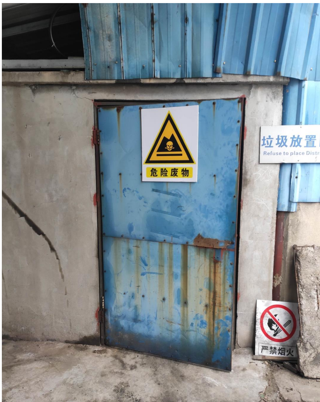
图 4-5 危险废物贮存场所
