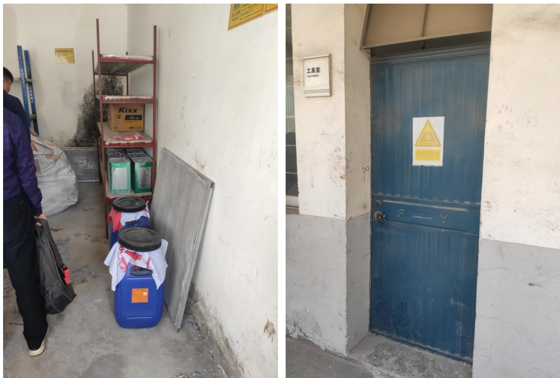
图 4-7 厂区东侧危险废物贮存场所
