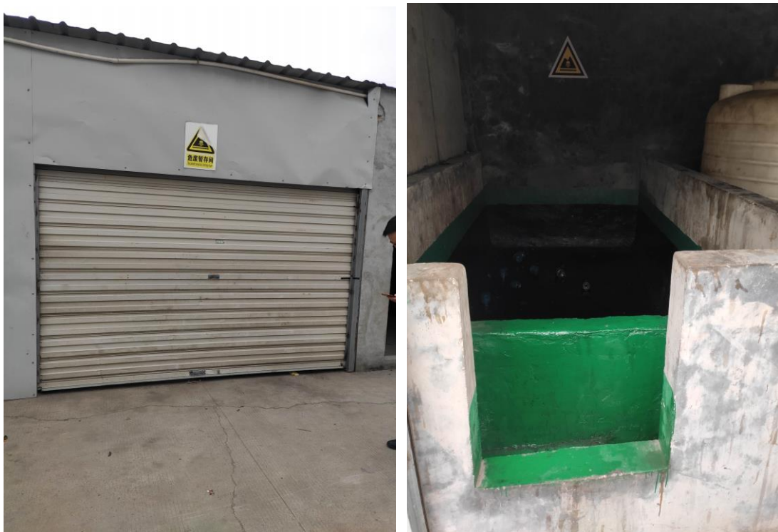
图 4-5 厂区南侧危险废物贮存场所
