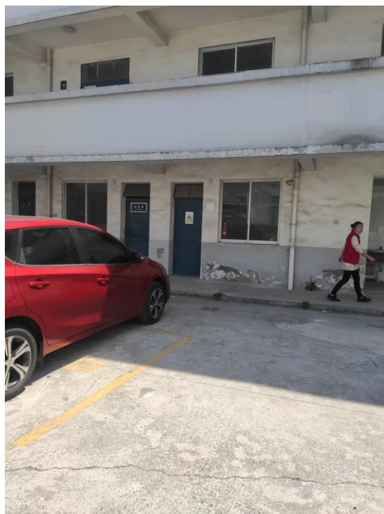
图 4-6 厂区东南侧危险废物贮存场所
