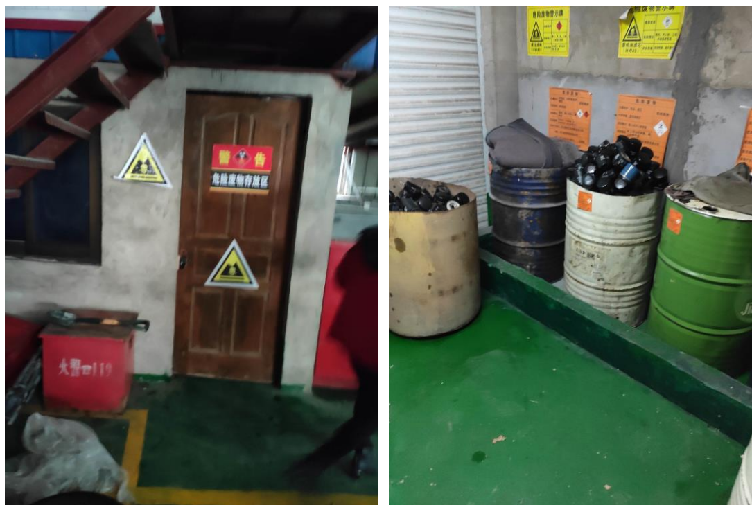
图 4-4 危险废物贮存场所
