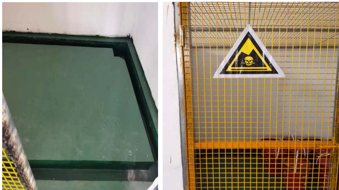
图 4-4 危险废物贮存场所
