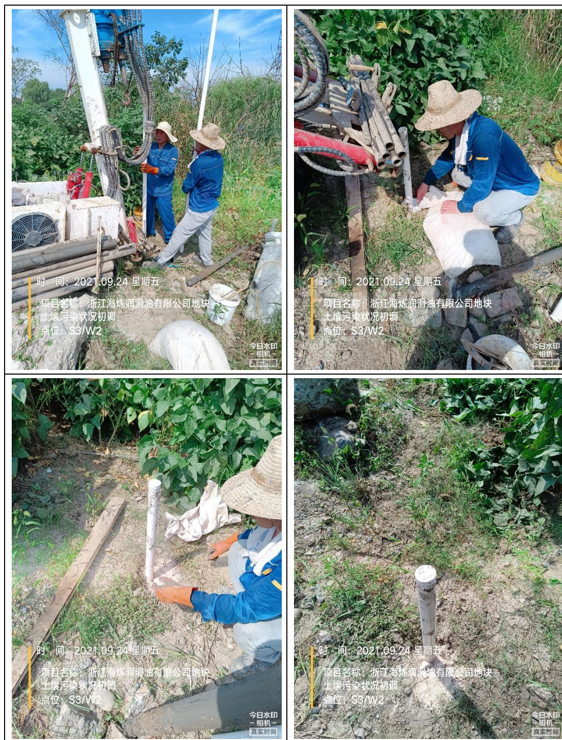
图6.2-6 建井过程现场照片
