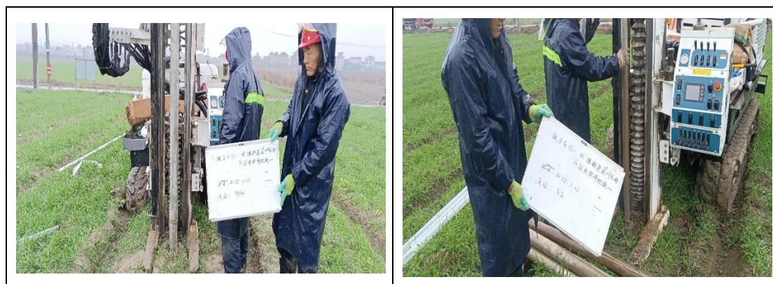
图 5.2-2 土壤钻孔现场照片
