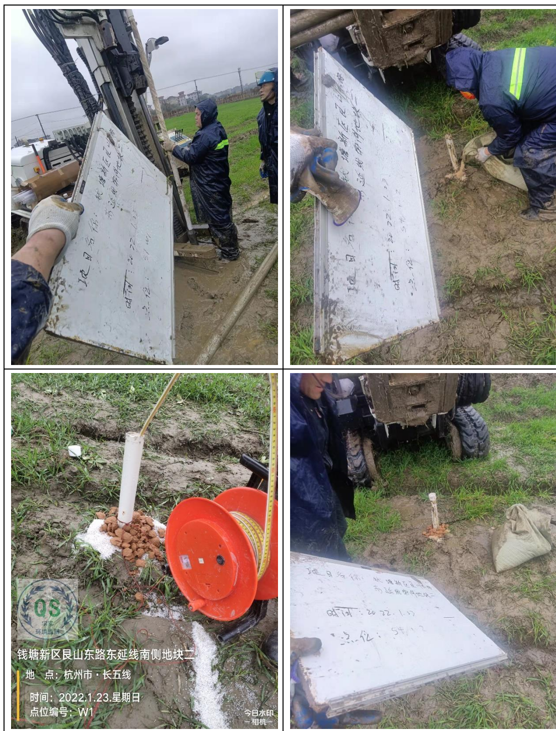
图5.2-6 建井过程现场照片
