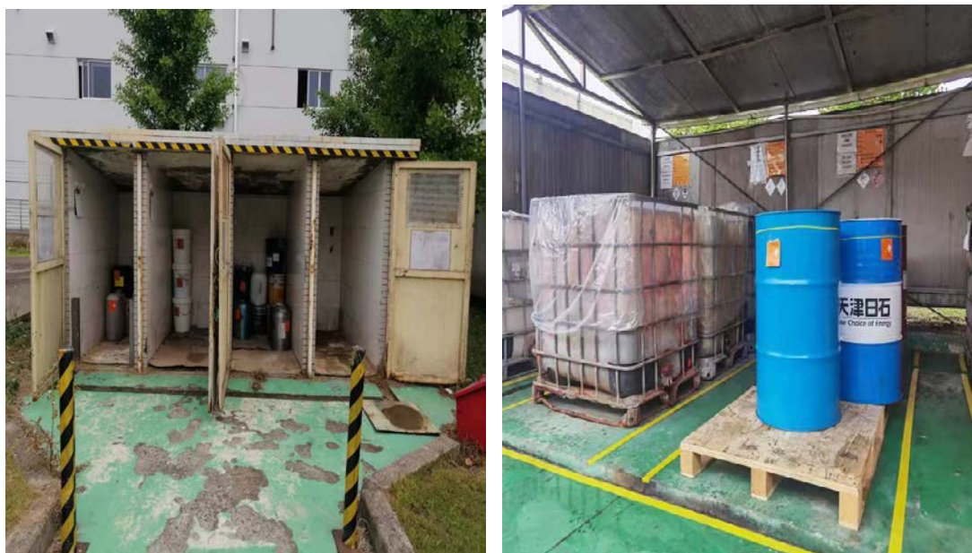
图 4-3 危废暂存库照片
