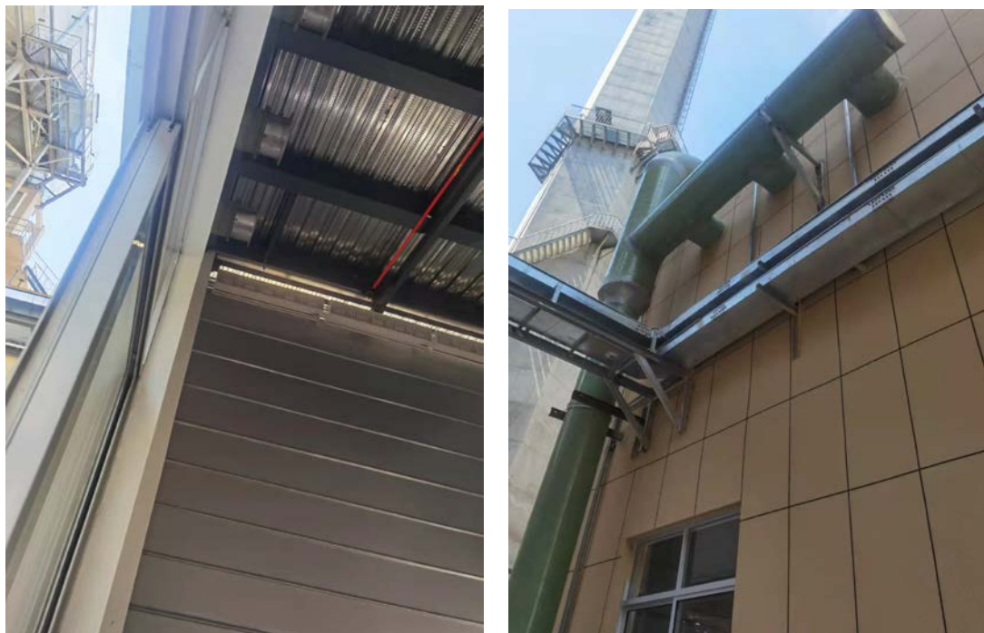
图 4-3 污泥储运系统臭气废气收集设施图
