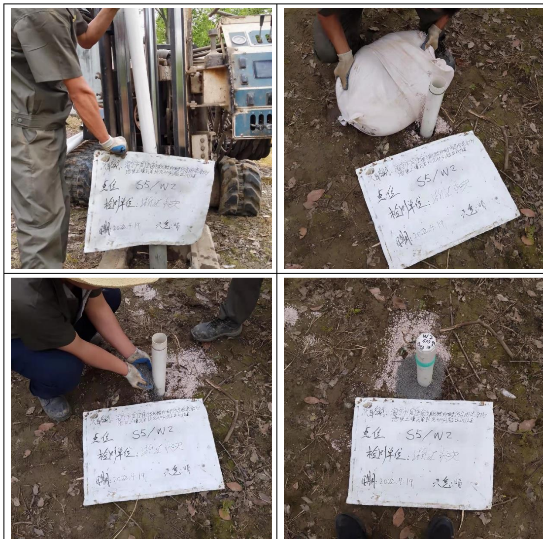
图5.2-6 建井过程现场照片
