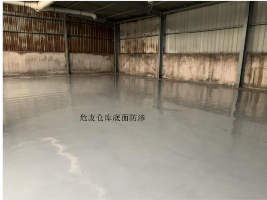
危废仓库地面防渗
