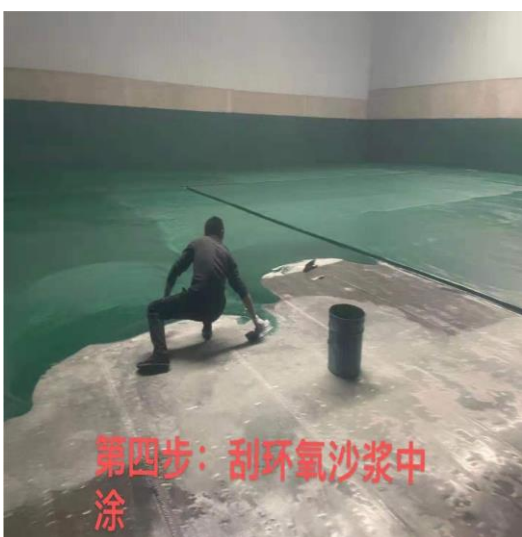
图 4-8 贮存间及生产区域等防腐防渗处理部分现场施工图
