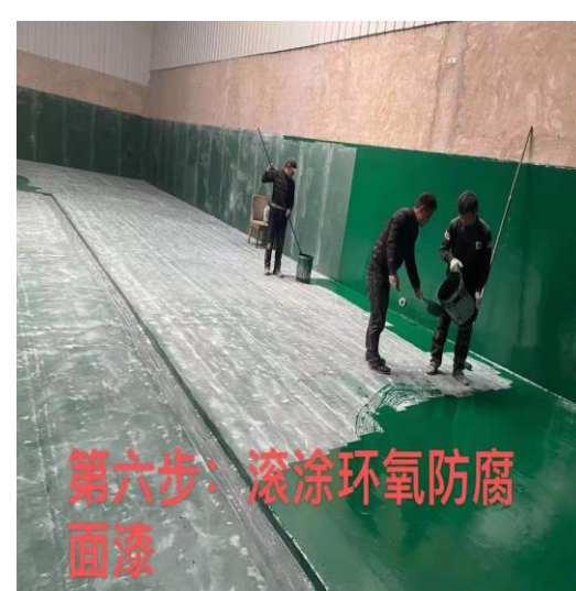
图 4-8 贮存间及生产区域等防腐防渗处理部分现场施工图
