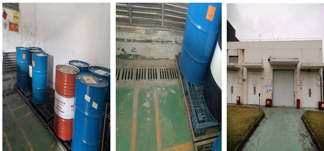
图 4-3 危废暂存库照片
