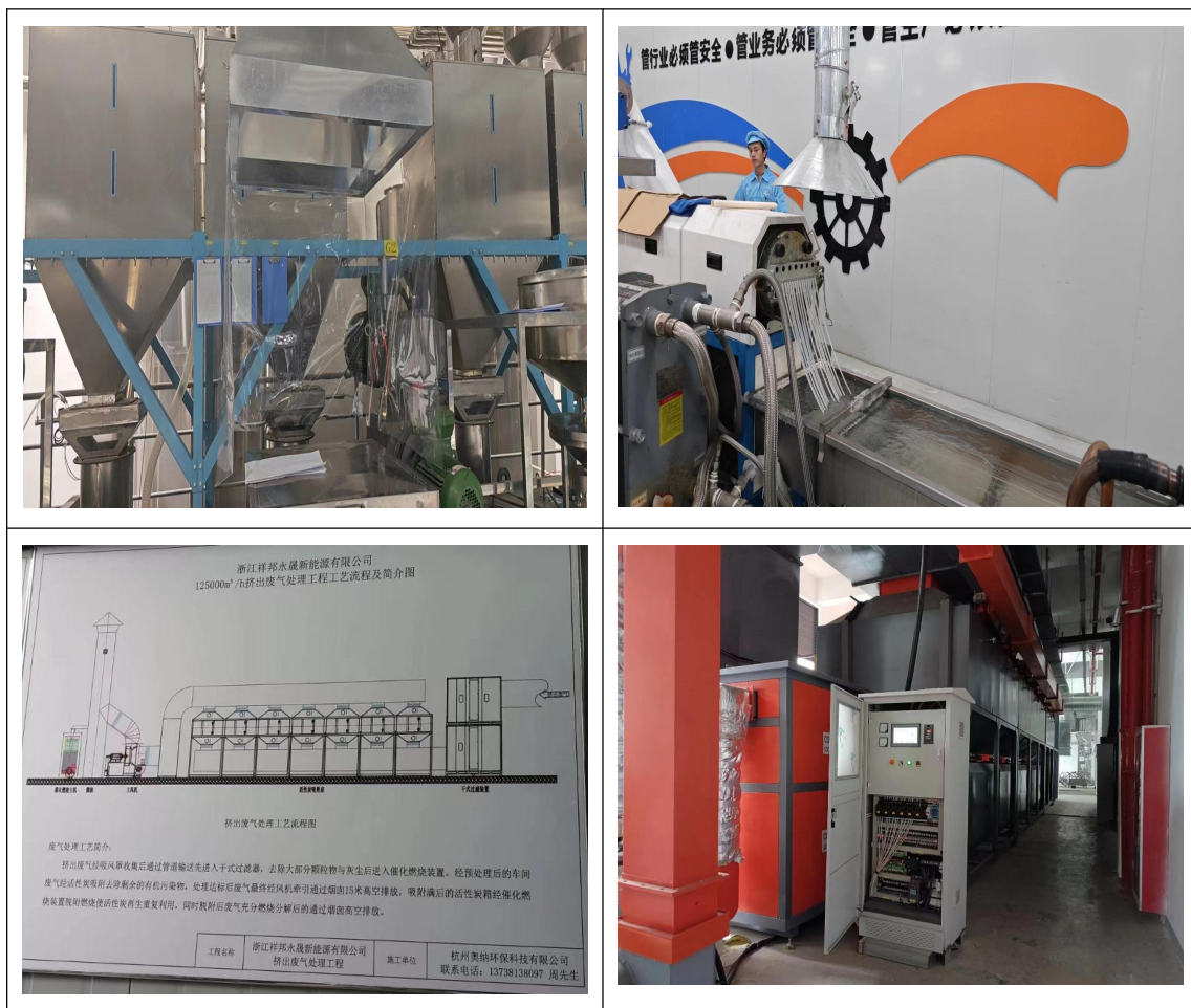
图 4-3 项目废气收集处理装置
