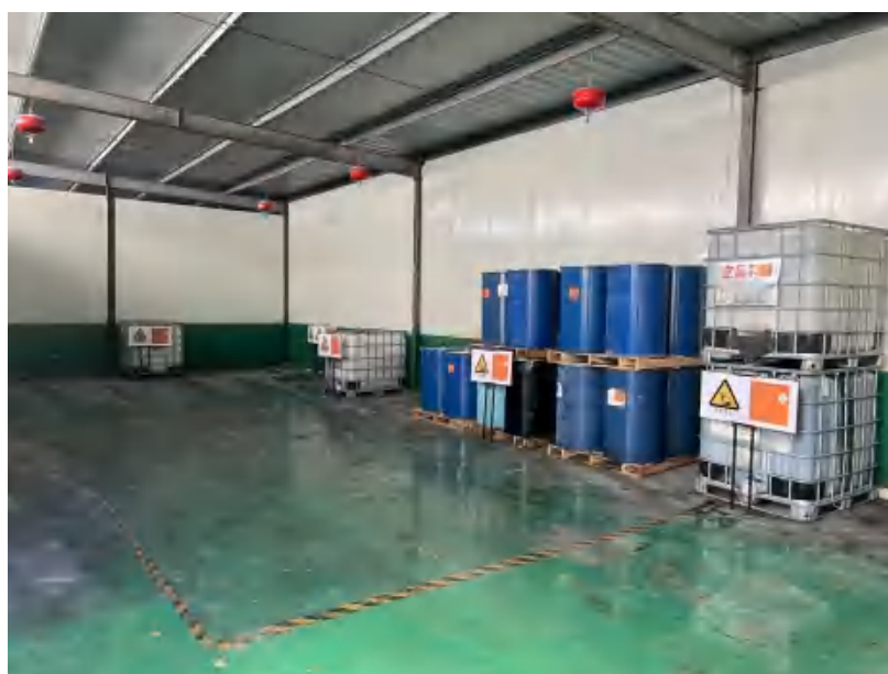
图 4-5 项目危废仓库暂存间
