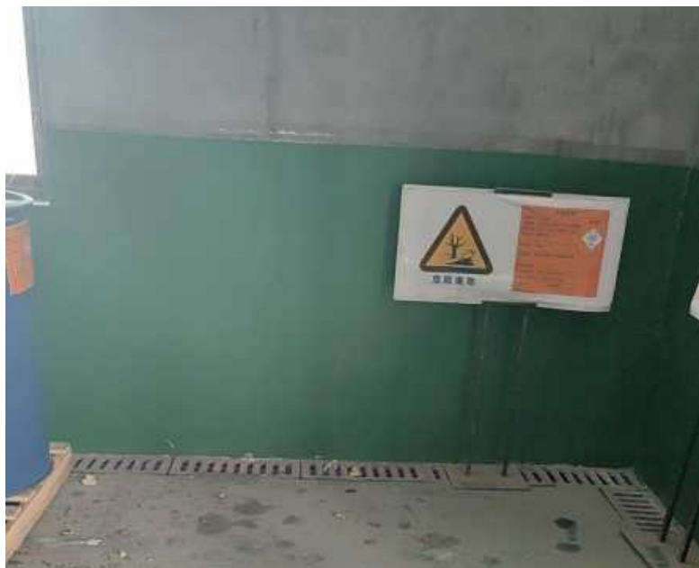
图 4-5 项目危废仓库暂存间
