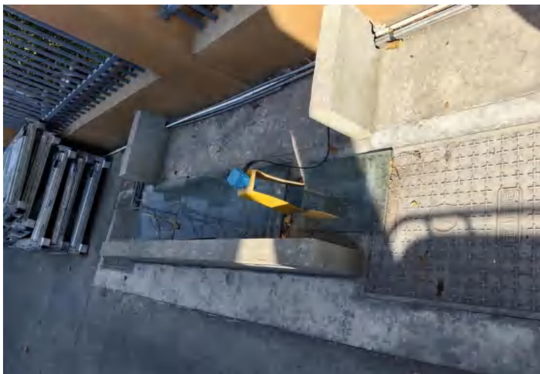
图 4-2 项目废水处理设施
