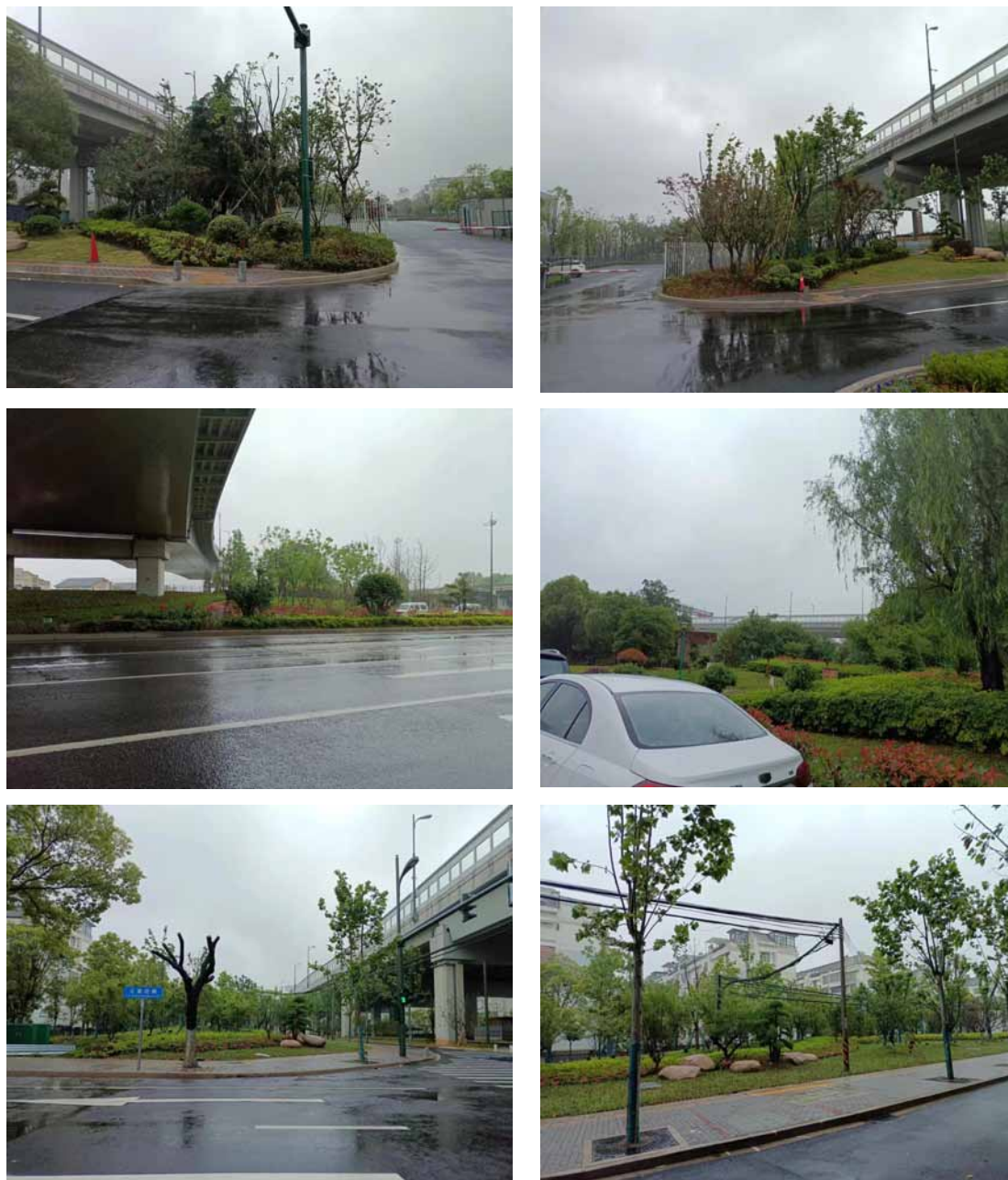
图 7.2-1 工程绿化及护坡照片
