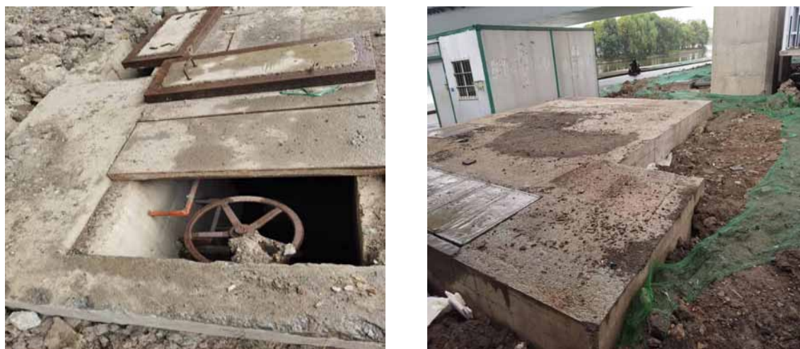
图 11.2-2 风险防范措施及排水收集照片
