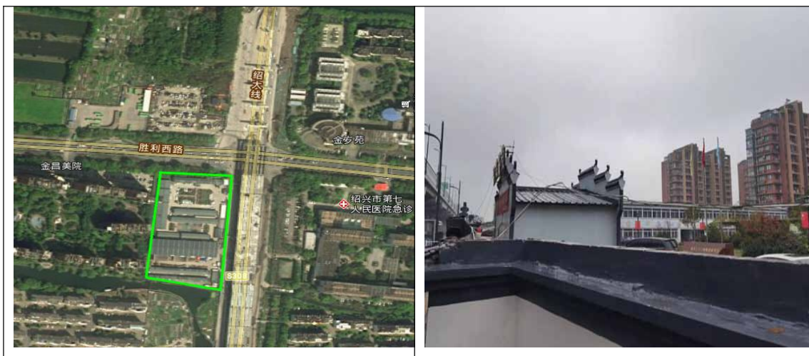
图 5.5-2 施工临时场地位置及现场照片
