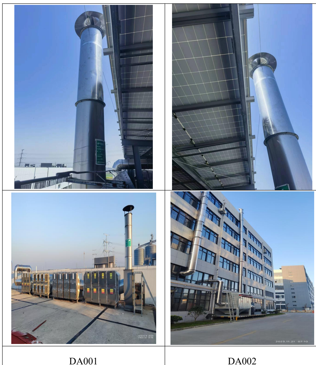
图 4-9 项目排放口标识标牌落实情况
