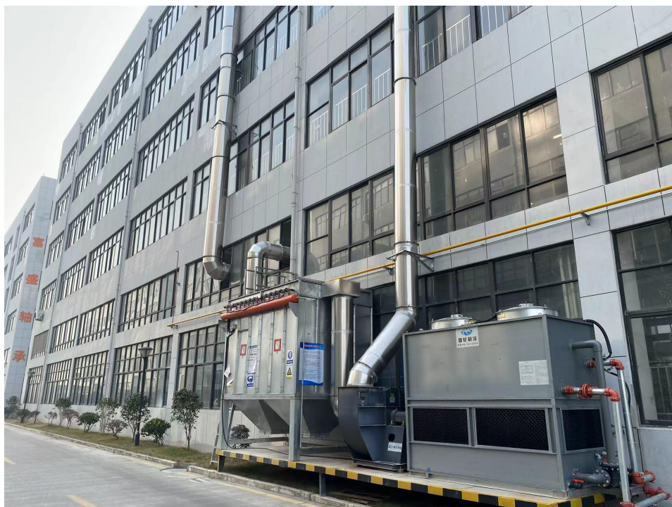
图 4-6 项目破碎、筛分废气收集处理情况
