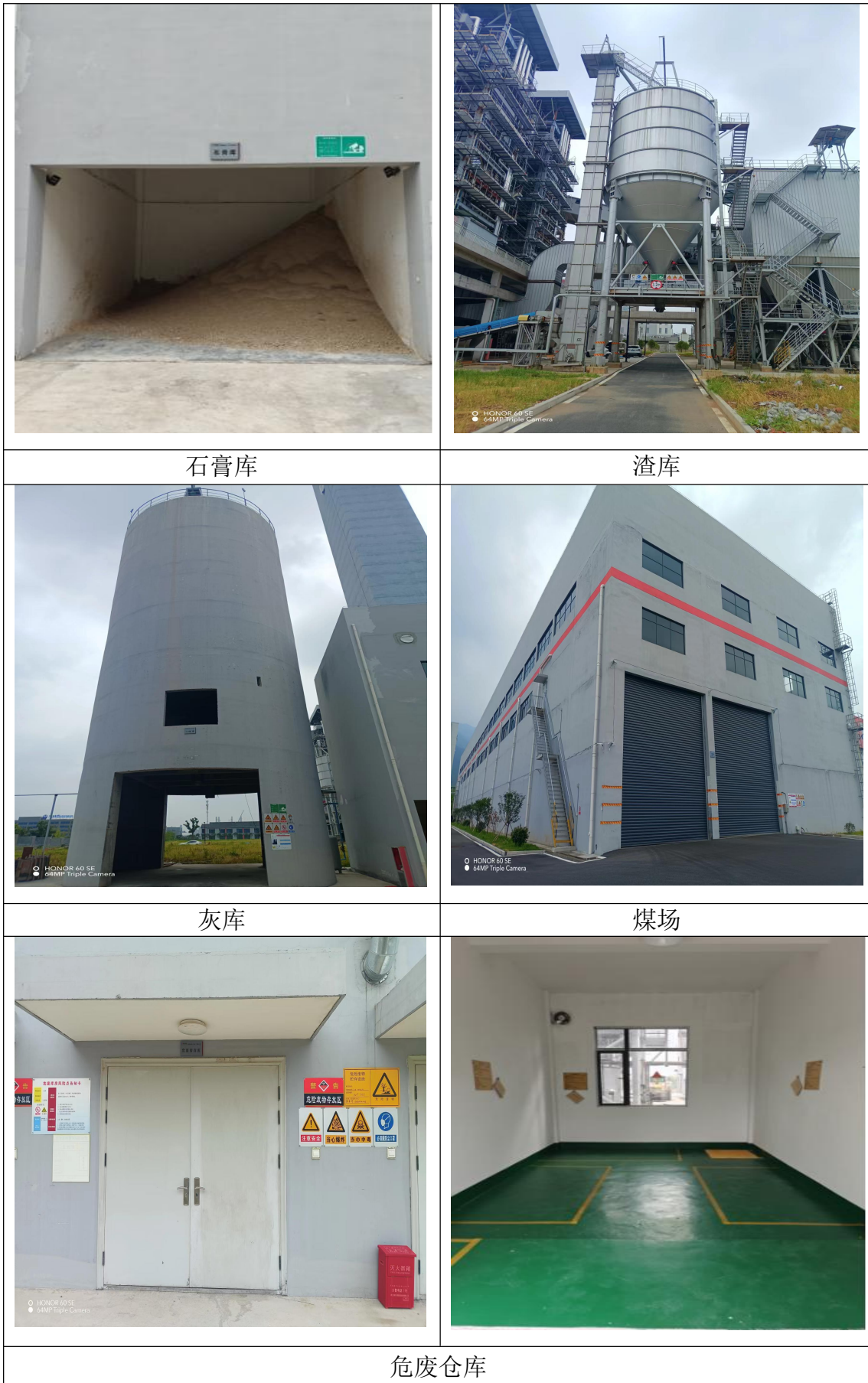
图 4-7 危险废物贮存图
