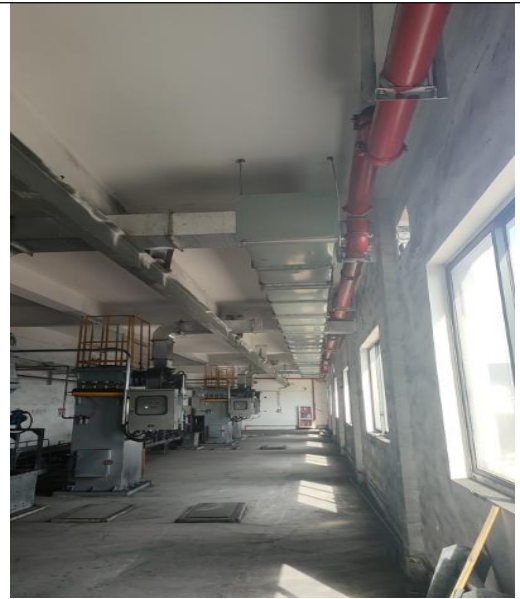
炉前煤仓处理设施
