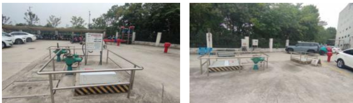
图 5.1-12 2023 年后新应急池现场照片
