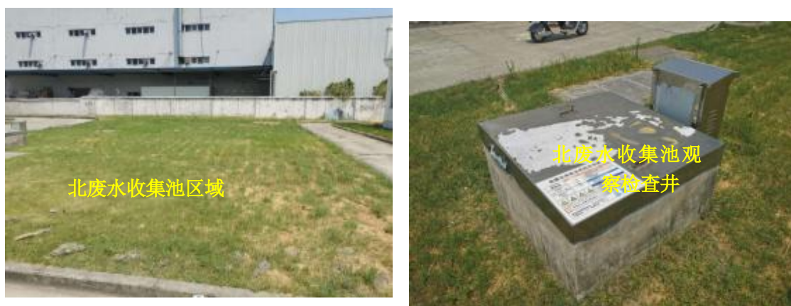
图 5.1-11 北废水收集池现场照片
